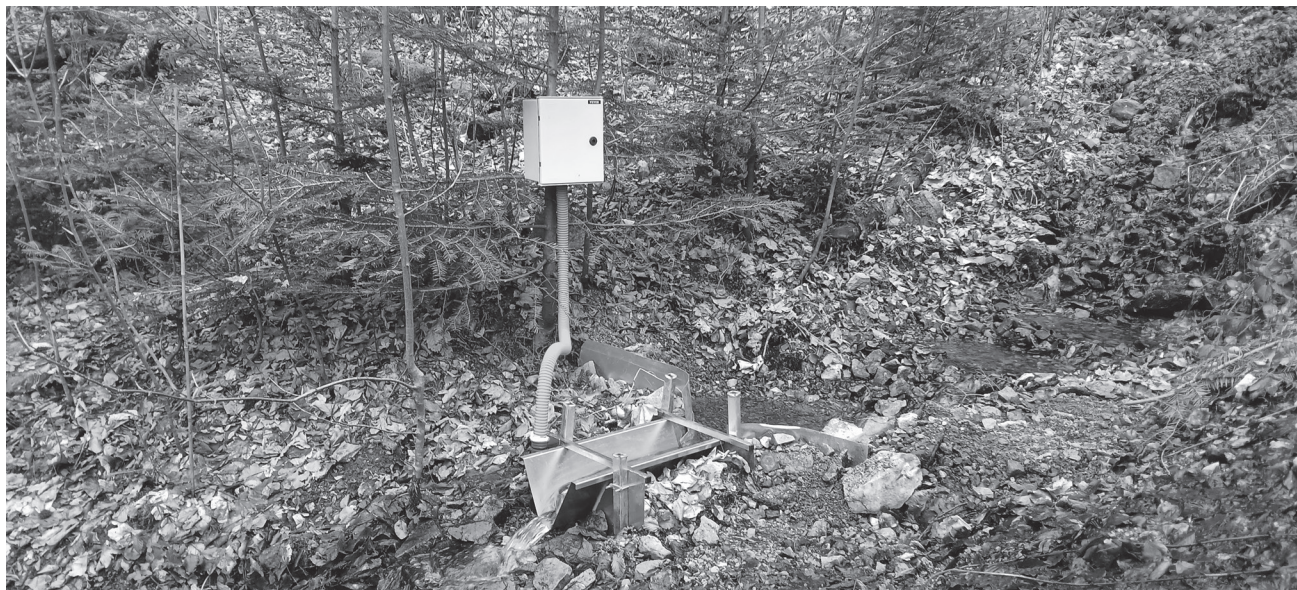
7.1. Station de suivis du débit de la fontaine Saint-Pierre (cliché Bibracte / J.Cacot).
